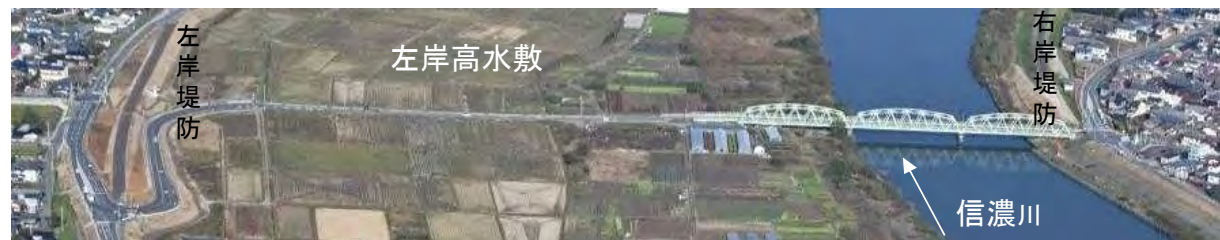
平常時 小須戸橋を上流より望む H22.10撮影
