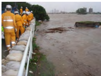
越水に対応するための積土のう工
