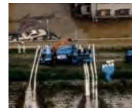
排水ポンプ車による排水
