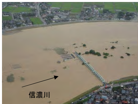
出水時の小須戸橋 撮影日:7/30
