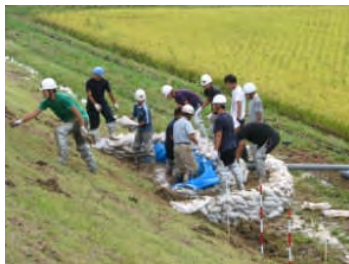
漏水に対応するための月の輪工
